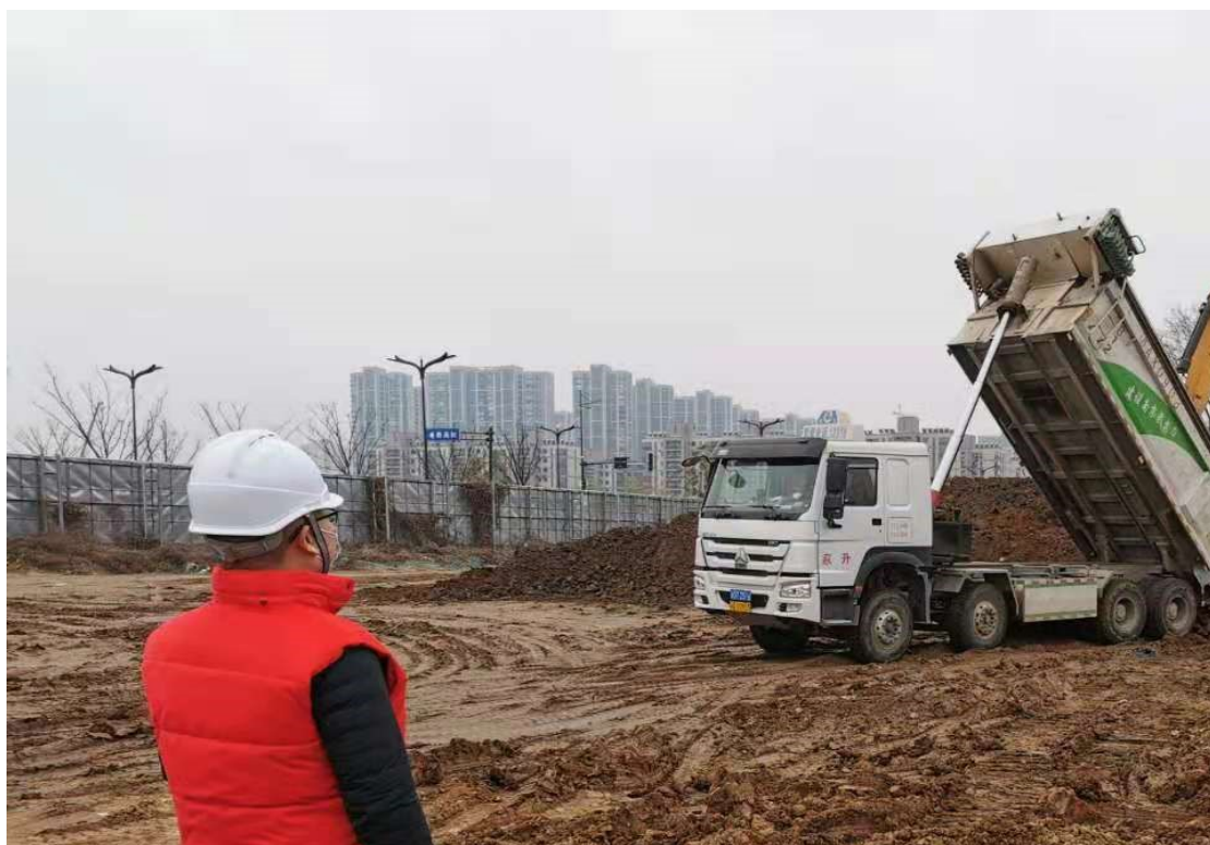
图 5.2-6 暂存区清洁土堆放
