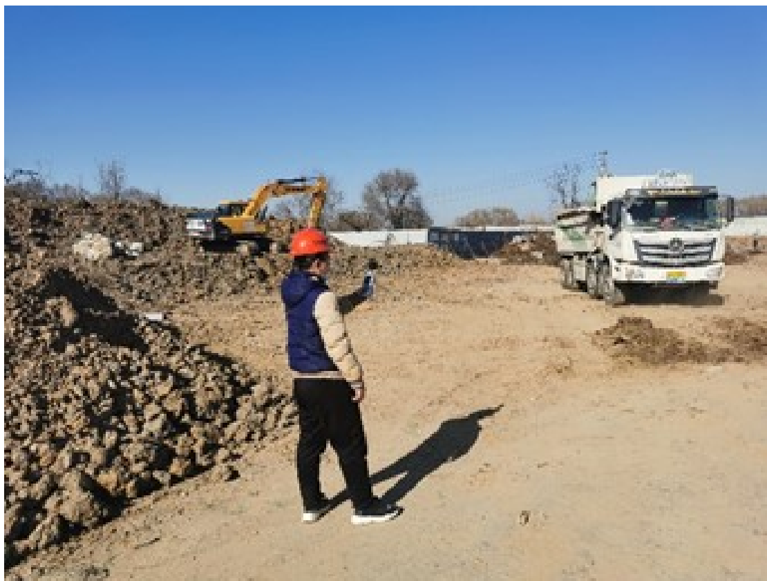
图 5.2-12 施工现场噪声检测
