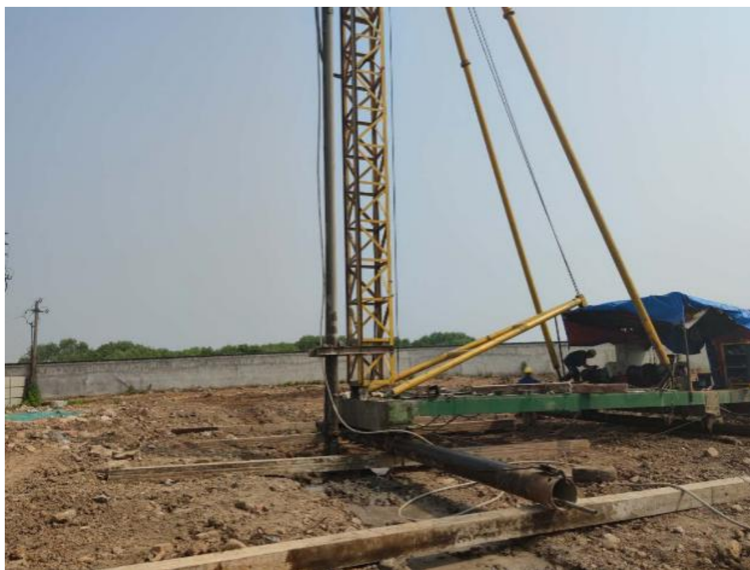
图 5.2-1 止水帷幕施工
