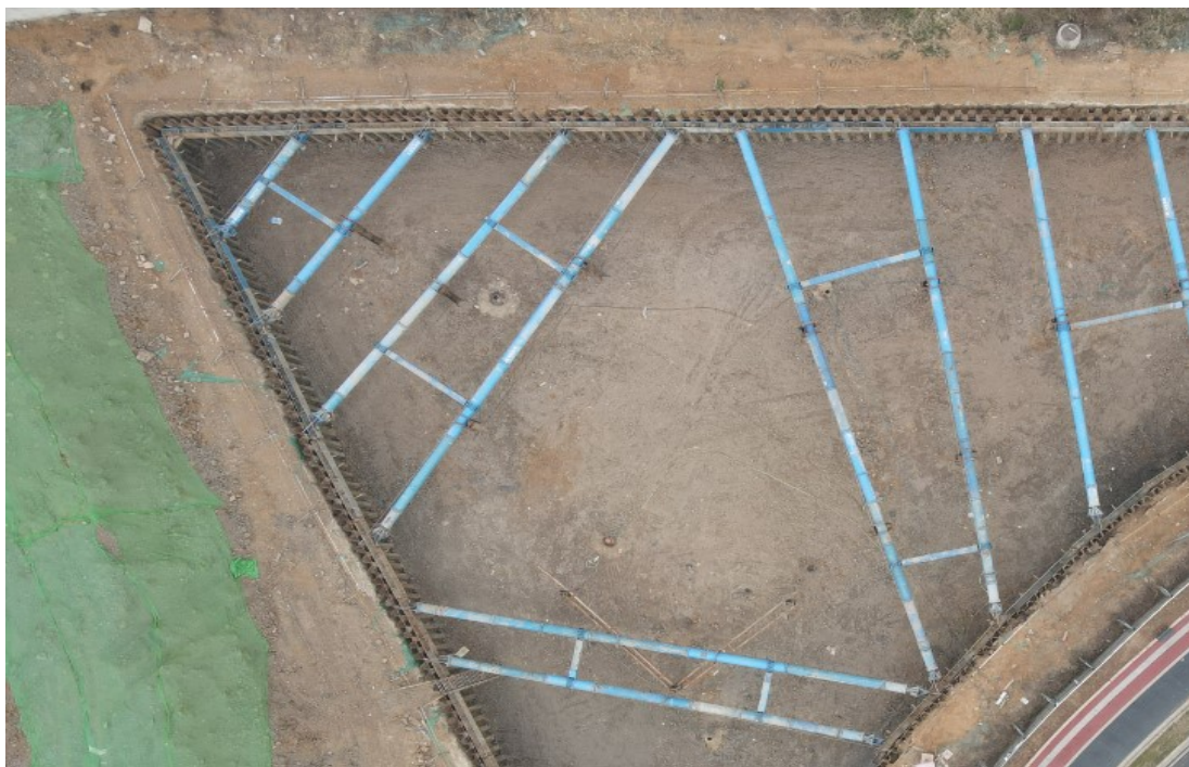
图 5.2-2 基坑支护
