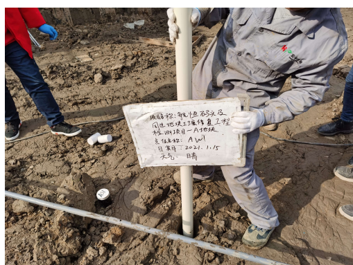
图 6.2-3 清挖基坑坑底建井
