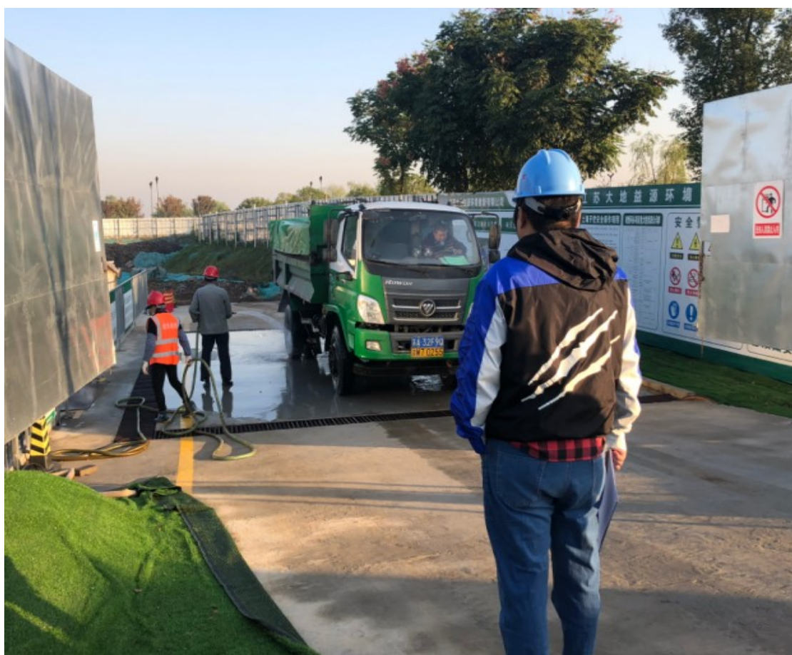
图 5.2-4 建筑垃圾冲洗
