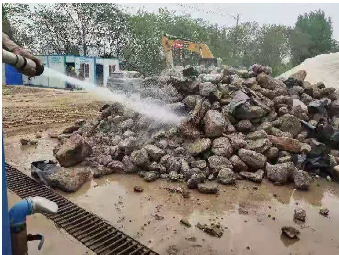
图 5.2-4 建筑垃圾冲洗
