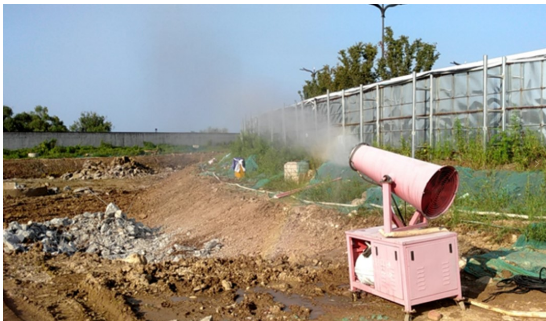
图 5.2-7 现场喷雾降尘设备
